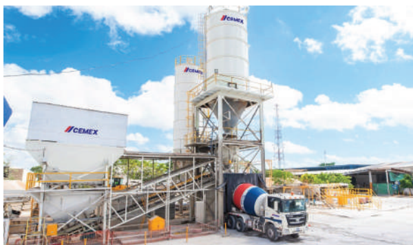
Imagen: Planta de concreto Cemex, Monterrey Fuente: Cemex
